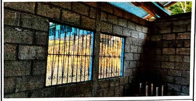
Foto 6: Mantenimiento de estructura
