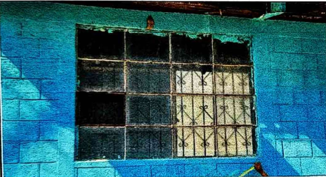
Foto 3: Cambio de vidrios
