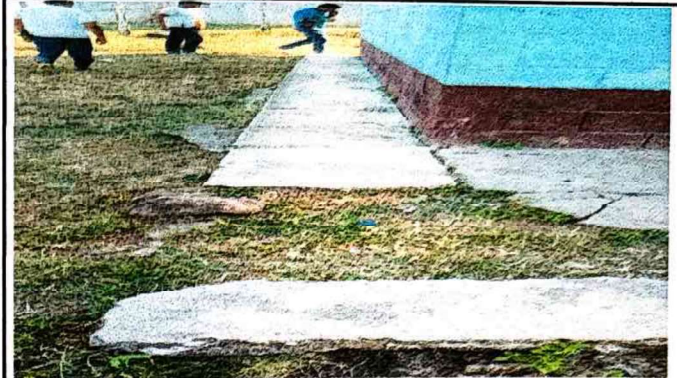
Foto 2: Reparación de corredor de 3 aulas y dirección lado atrás
