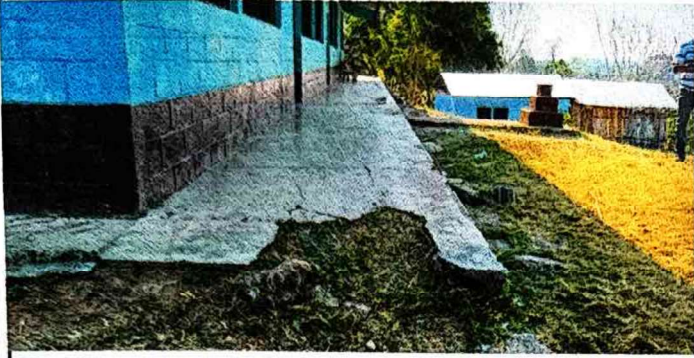
Foto 1: Reparación de corredor de 3 aulas y dirección lado enfrente
