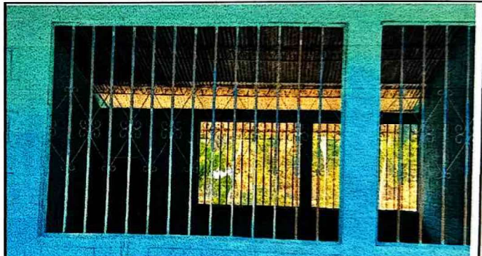
Foto 4: Mantenimiento y reparación de balcones
