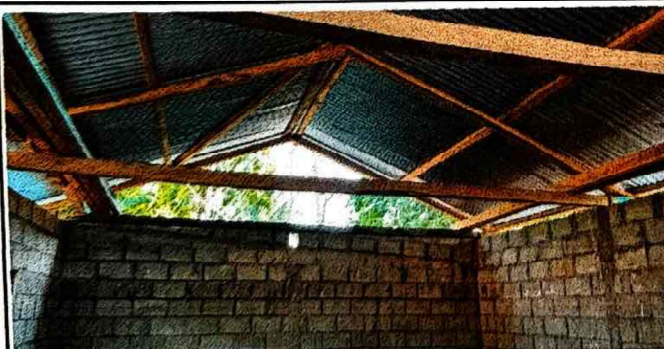
Foto 5: Cambio estructura y techo
